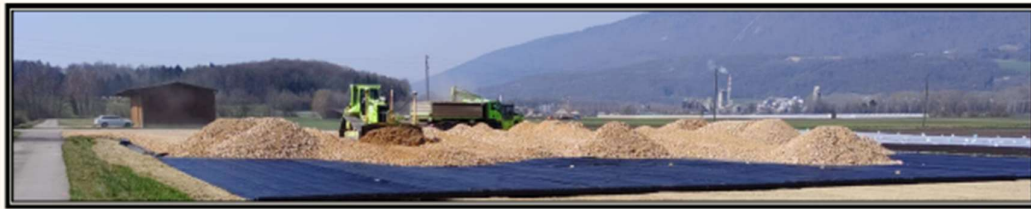
Bau des BUP in Gals
