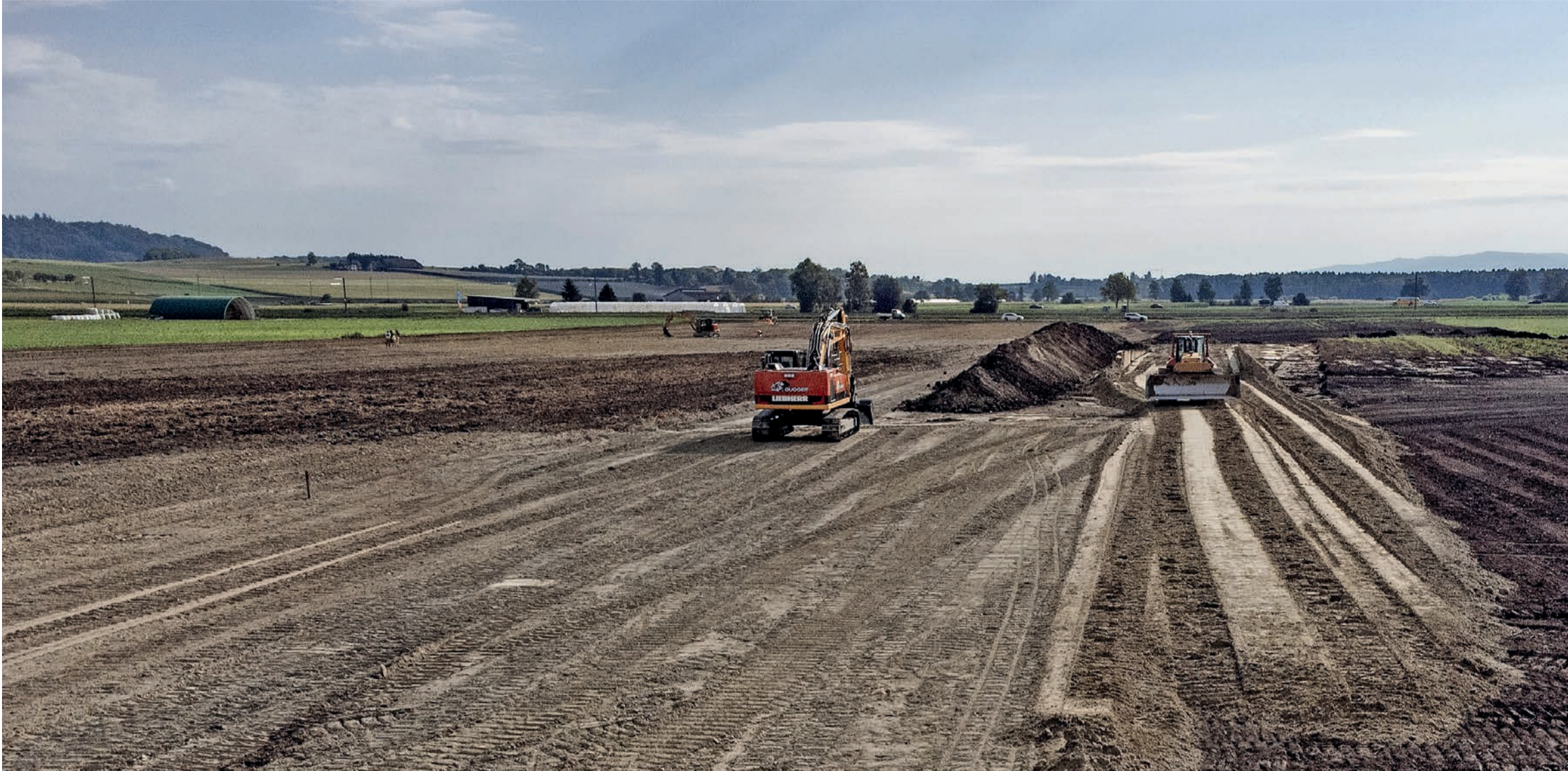
Bodenaufwertung bei Ins: Schwere Maschinen mischen hellen Sand und dunkle Erde.
