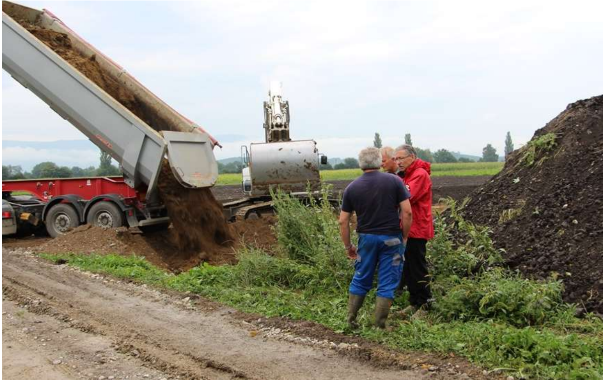
Abb. 2. Auffüllen einer Senke bei Kallnach im Sommer 2014 ; auf einer Fläche von 7'500 m 2 werden 8'000 m 3 Bauaushub eingebracht, antransportiert von einer Baustelle in Bern; Regierungsstatthalte Gerhard Burri (rote Jacke) diskutiert die rechtliche Problematik mit dem Grundeigentümer und dem zuständigen Gemeinderat.
